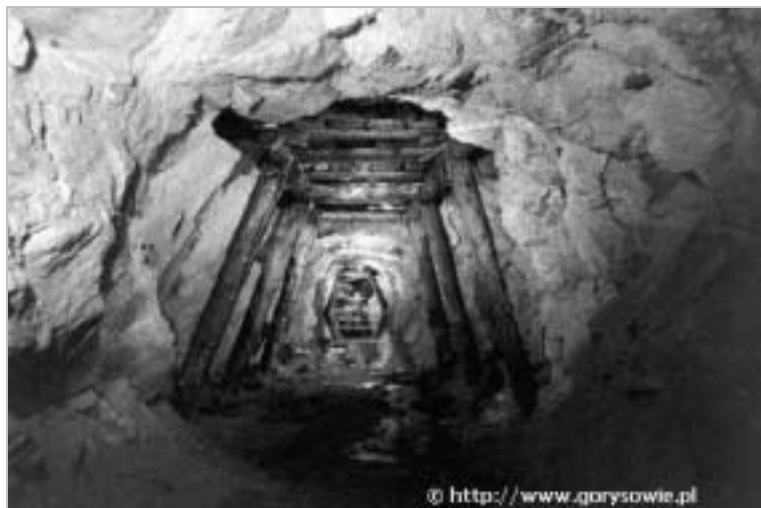
Rys. 8. Wyrobisko w obudowie drewnianej (kompleks „Włodarz”) Fig. 8. Excavation in wooden support (“Włodarz” Complex)
