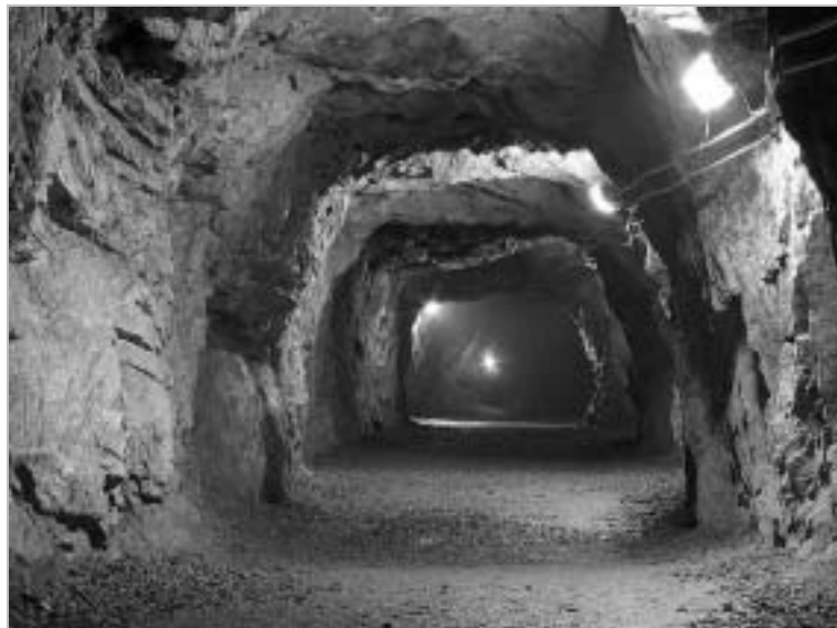
Rys. 7. Wyrobisko bez obudowy (Sztolnia III w kompleksie „Rzeczka”) Fig. 7. Excavation without support (Adit No III in “Rzeczka” Complex)
