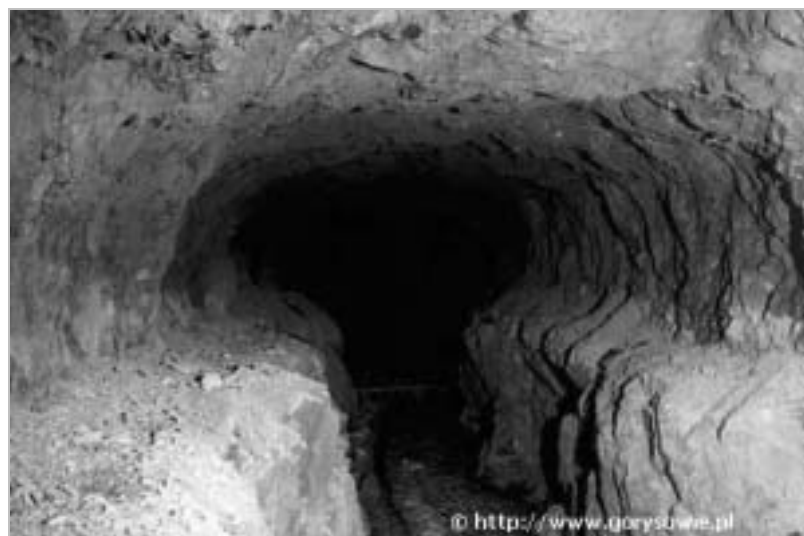
Rys. 4. Pierwszy etap wykonywania wyrobiska o dużych gabarytach (kompleks „Osówka”) Fig. 4. First stage forming of a large excavation (“Osówka” Complex)
