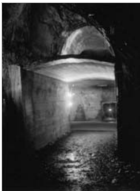
Rys. 9. Wyrobisko z przedziałem wentylacyjnym w stropie (kompleks „Osówka”) Fig. 9. Excavation with ventilation shaft („Osówka” Complex)
