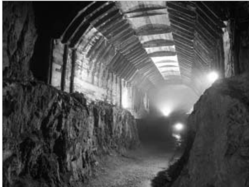
Rys. 3. Hala nr 1 (kompleks „Osówka”) Fig. 3. Hall No. 1 (“Osówka” Complex)
