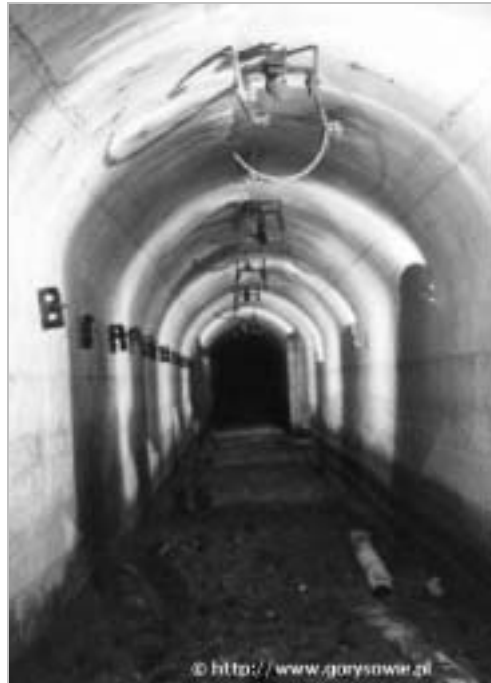
Rys. 5. Wyrobisko w obudowie betonowej (kompleks „Książ”) Fig. 5. Excavation in concrete support ("Książ" Complex)
