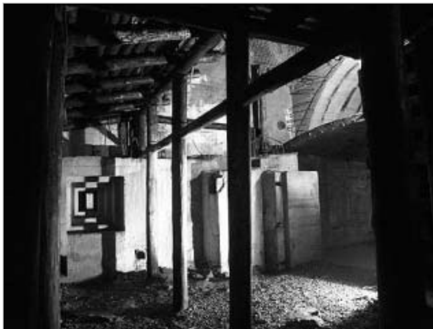
Rys. 6. Wartownia wykonana w obudowie betonowej (kompleks „Osówka”) Fig. 6. Guard-house ("Osówka" Complex)
