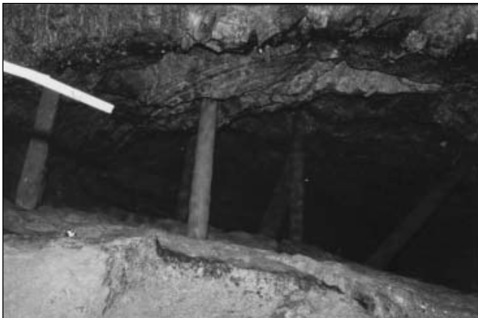
Rys. 4. Zatopiony szybik kopalni w Bystrzycy Górnej. (fot. M. Madziarz, 1994) Fig. 4. Flooded small shaft in a mine in Bystrzyca Górna (phot. M. Madziarz, 1994)
