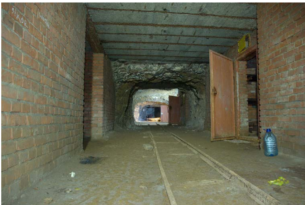
Rys. 8. Komora materiałów wybuchowych na III poziomie kopalni „Konstanty” (fot. D. Wójcik) Fig. 8. The explosives storage chamber on the 3rd level of the „Konstanty” mine (photo by D. Wójcik)
